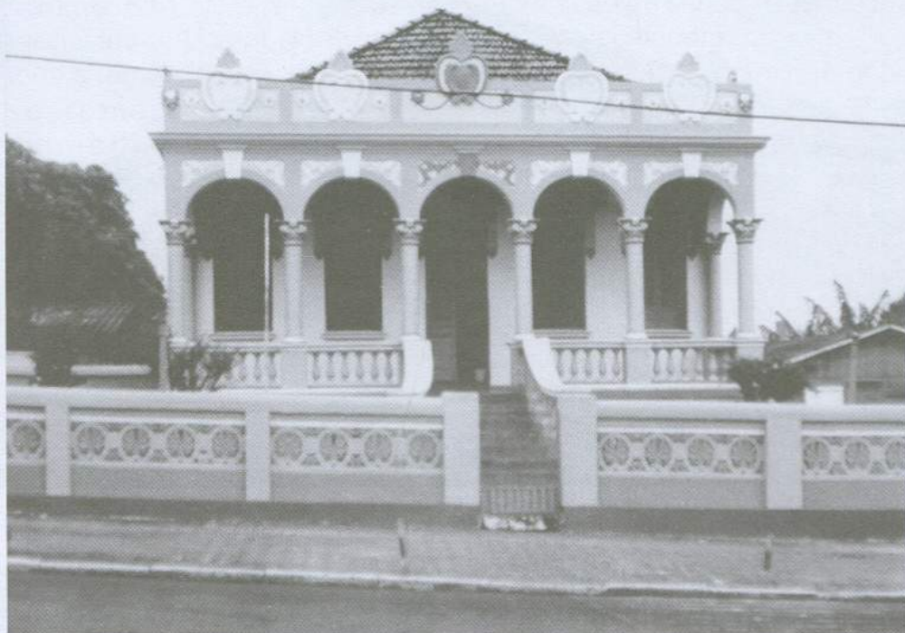
Residência localizada na Av. Imbiara. 2000. Acervo do CEM Centro Educacional Moderno/ Colégio Atena.
