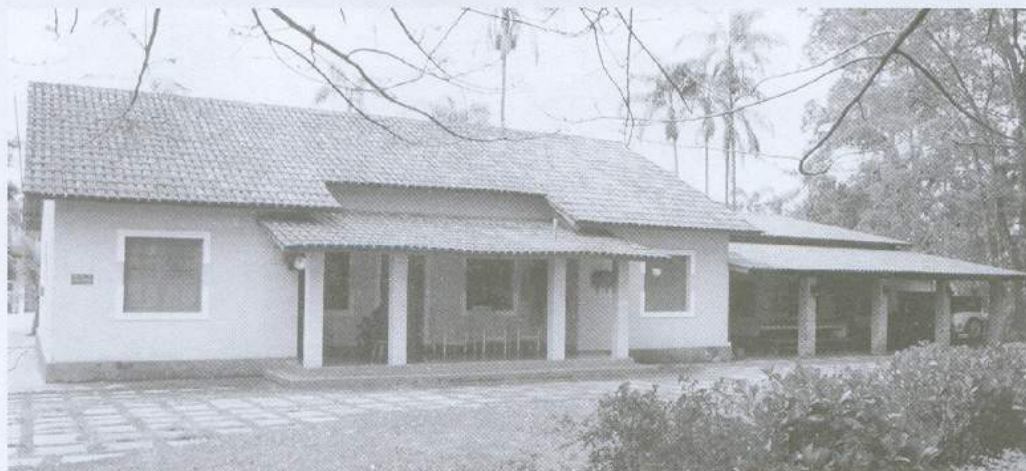
Fachada da Fazenda Pão de Açúcar.
