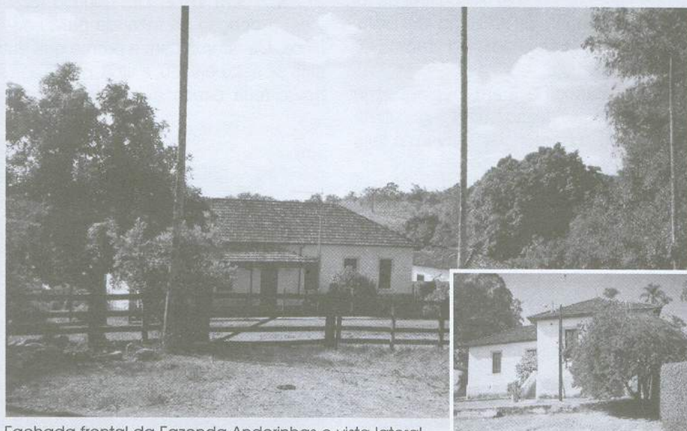
Fachada frontal da Fazenda Andorinhas e vista lateral.
