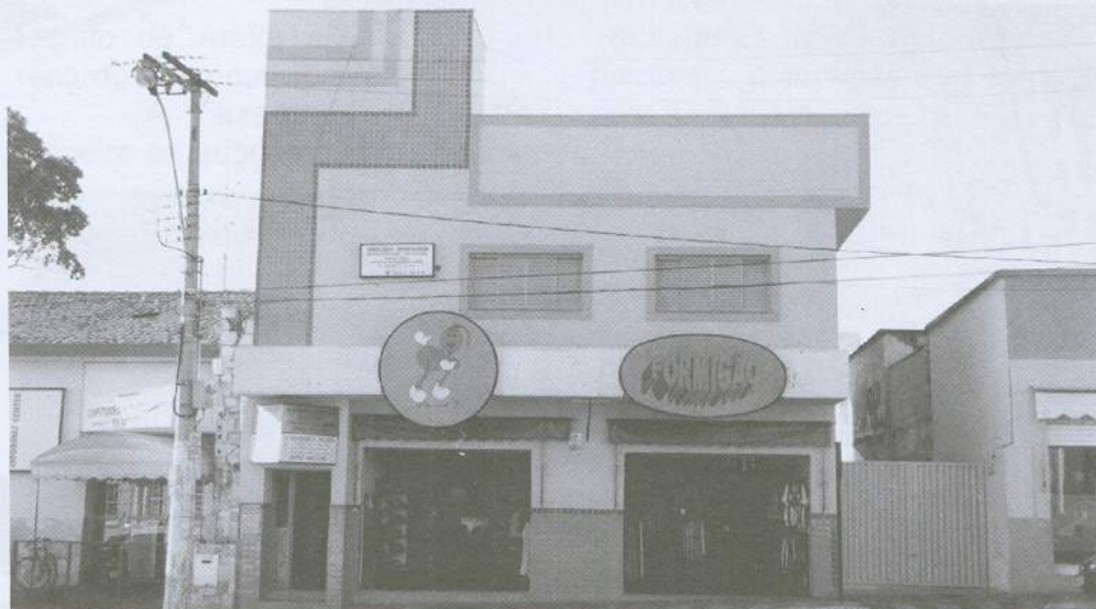
Hoje, prédio comercial localizado na Av. Antônio Carlos. 2004. Arquivo SAPP/FCCB.
