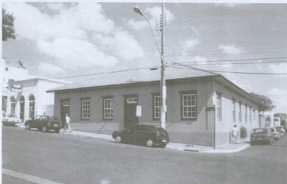
Residência localizada na esquina da Av. Antônio Carlos com a rua Cap. José Porfírio. 2004. Arquivo SAPP/FCCB.
