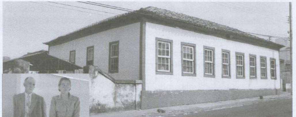
Residência Localizada na rua Alexandre Gondim. 2004. Arquivo SAPP/FCCB.
