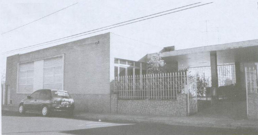
Residência localizada na rua Capitão José Porfírio. 2004. Arquivo SAPP/FCCB.
