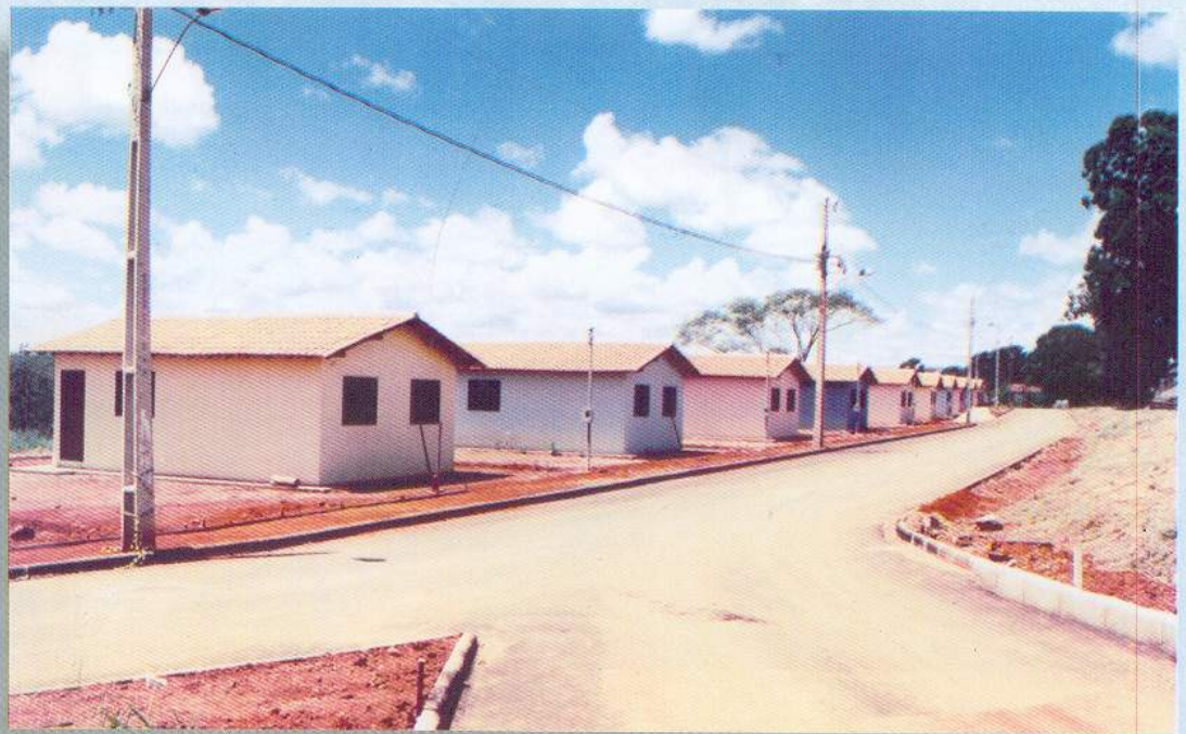
Construção da Agrovila de Itaipú com toda infra-estrutura.
