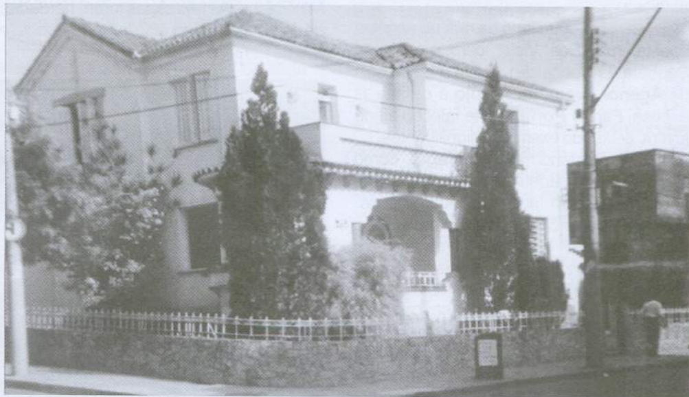
Residência localizada na rua Presidente Olegário Maciel, esquina com a rua Almeida Campos. 1984. Acervo José Sebastião Cheir Dib.
