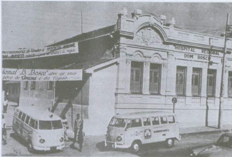
Antiga residência de Astolpho Rodrigues Valle e Luíza de Paula Carneiro. Na década de 1960 instalou-se aí o Hospital Regional Dom Bosco. Acervo Hospital Regional Dom Bosco.
